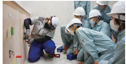
電気科生徒(第二種電気工事士資格取得者)の新体育館のコンセント取付け作業体験
