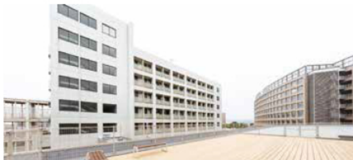
キャンパスの各棟を眺望できるデッキ(スカイデッキ)
