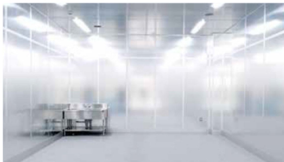
特定用途実験室(シールドルーム、暗室、ラマン分光室等の7室を配置)
