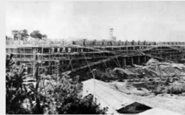
建設中の校舎(昭和37年頃)
