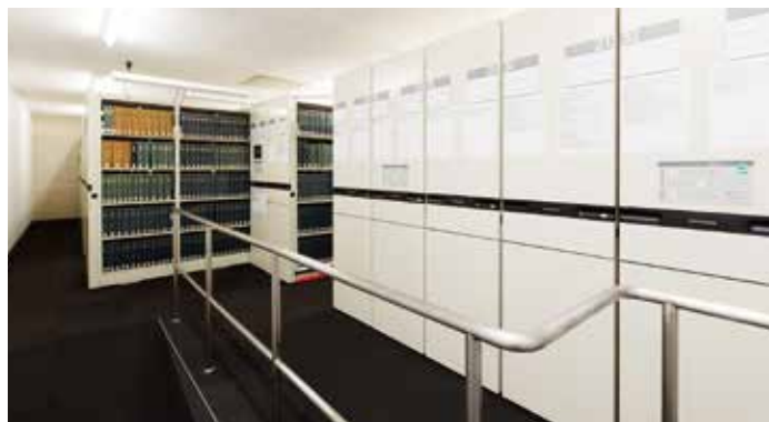
多様な学習スペースを確保するための電動集密書庫
