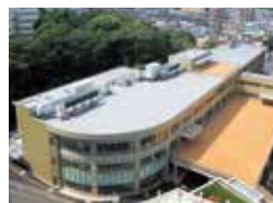
最新式環境配慮・省エネ型の空調システム(屋上)
