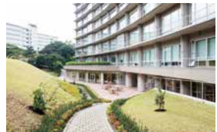
遊歩道&屋外カフェテラス(B棟)
