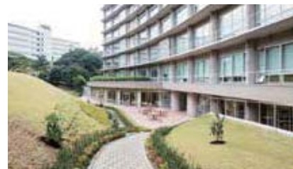
遊歩道&屋外カフェテラス (B棟)
