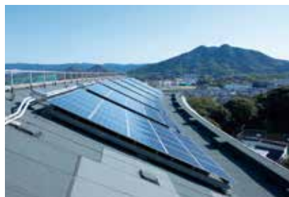
A棟ソーラーシステム更新
